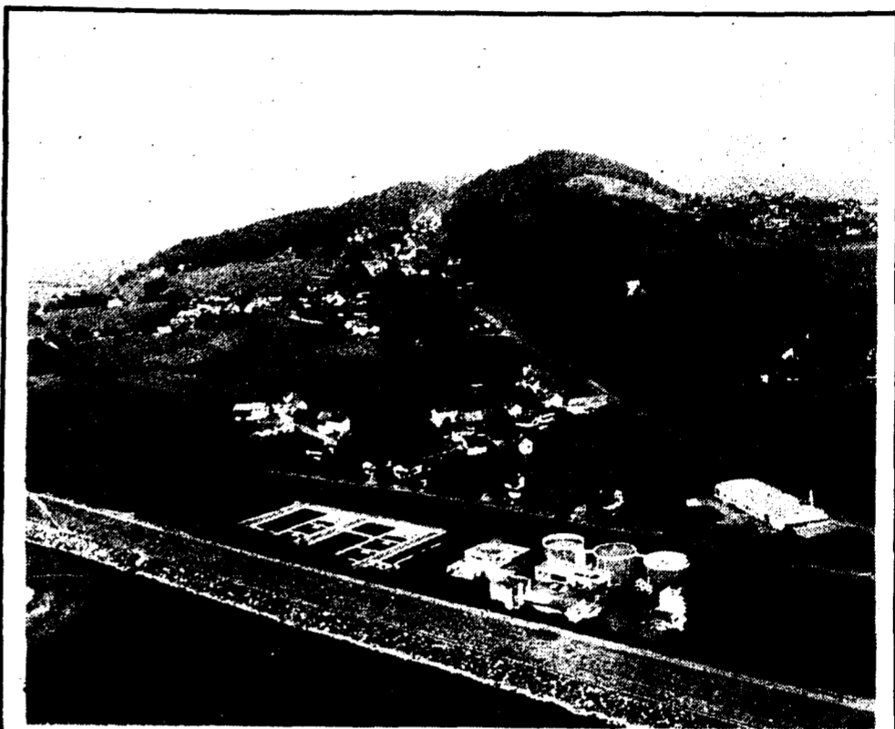
Seit zehn Jahren ist die Abwasserreinigungsanlage in Bendorf in Betrieb. Sie ist das Gemeinschaftswerk der Unterländer Gemeinden und der Gemeinde Schaan. Am Samstag kann die Anlage im Rahmen eines Tages der offenen Türe besichtigt werden. (Archivbild)
