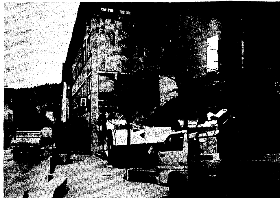
Der Engländerbau in Vaduz wird mit einem Kostenaufwand von 1,650 Millionen Franken saniert, damit Teile der Fürstlichen Sammlungen, die im Juni aus New York zurückkommen, wieder ausgestellt werden können. Bei den Sanierungsarbeiten geht es vor allem um die sicherheitstechnischen Aspekte und die Klimatisierung, die im heutigen Zustand ungenügend sind. Bis August wird noch die Ausstellung «Wiener Biedermeier» gezeigt, nach Abschluss der Sanierungsarbeiten gibt es eine Ausstellung über «Flämische Malerei».
