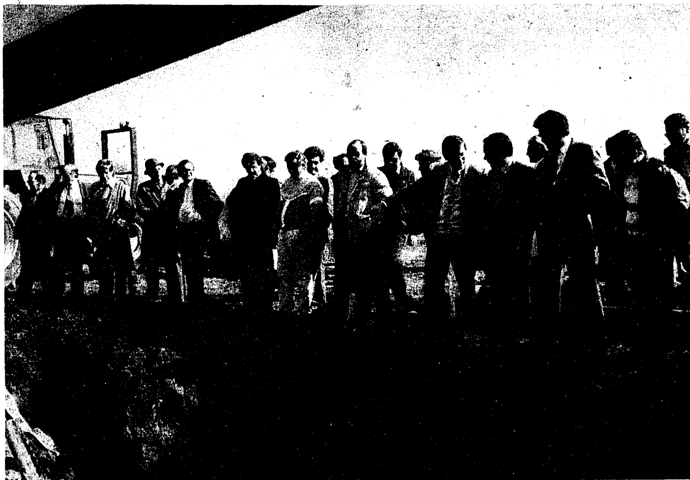
Gestern vormittag wurde die Baustelle zur Erdgasversorgung in Ruggell offiziell eröffnet. Der Spatenstich war eigentlich schon vorher gemacht worden, denn bereits sind rund dreihundert Meter Erdgasleitung fertig verlegt und weitere Streckenabschnitte zur Verlegung bereit. Unser Bild zeigt Verwaltungs- und Aufsichtsräte der Erdgasversorgung sowie beteiligte Unternehmen und Abnehmer an der Besichtigung der Baustelle im Ruggeller Riet. Sechster von links Regierungschef-Stellvertreter Hilmar Ospelt, der Präsident des Verwaltungsrates der Erdgasversorgung. (Bild: Brigitt Risch)
