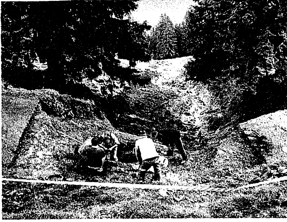
Auf einer Länge von rund zehn Metern wurde gestern Dienstag die Strasse zwischen Sücka und dem alten Tunnel weggerissen. Die starken Regenfälle der letzten Tage sind die Ursache dafür, dass nach ersten Schätzungen rund 1000 Kubikmeter Erdmaterial abrutschten. An der Abrutschstelle wurde die Wasserleitung Malbun-Vaduz entzweigerissen.
