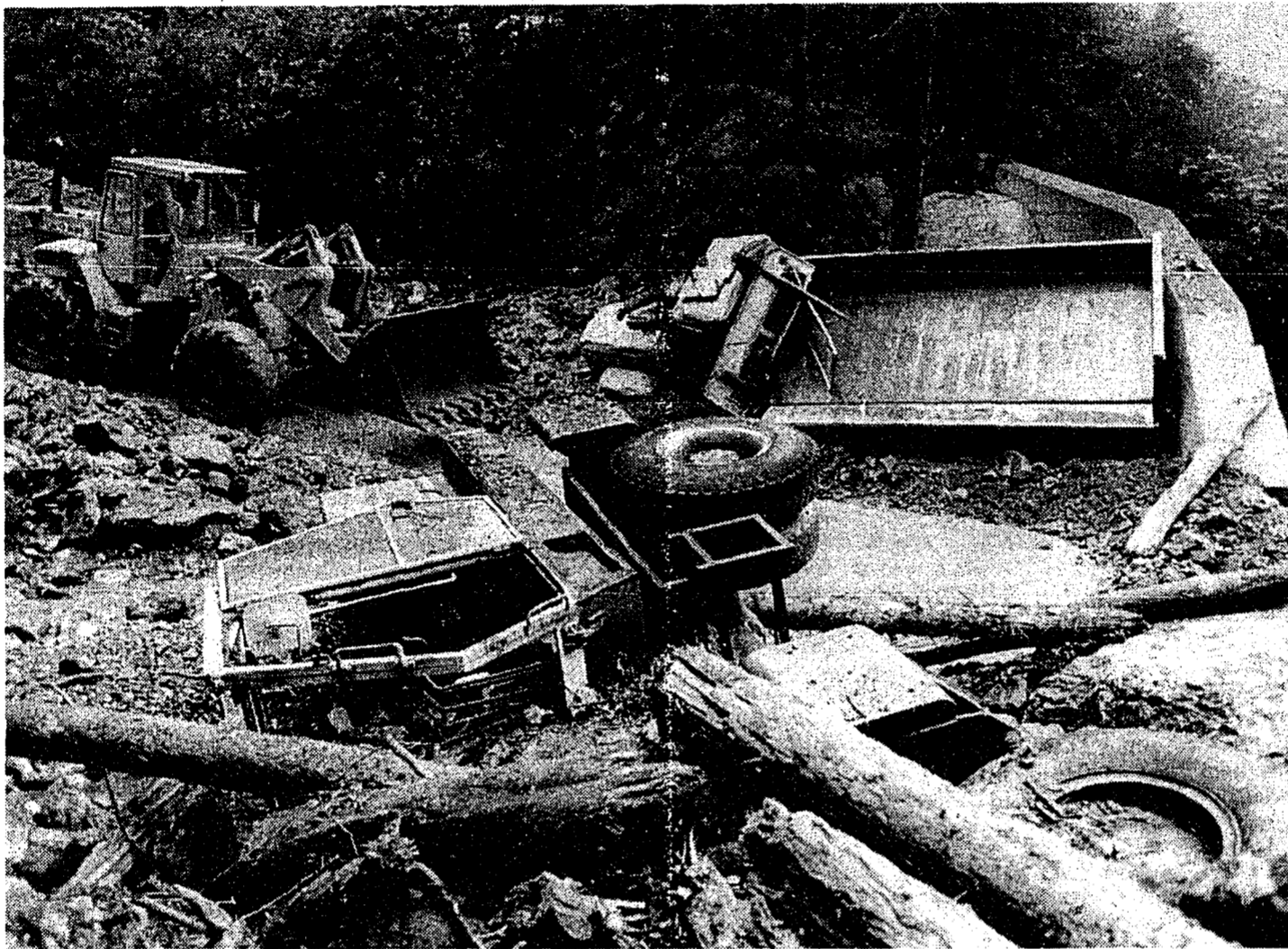
Glück im Unglück für einen Baggerführer und einen Lastwagenchauffeur am Montagnachmittag in einem Sammler der Forstrüfe oberhalb der Fürstin-Elsa-Brücke an der Strasse nach Planken: mit riesiger Gewalt wurden die beiden Fahrzeuge von einem unerwartet starken und unverhofften Rüfeniedergang etwa 50 bis 60 Meter weit mitgeschwemmt und blieben dann rechts und links von der Sperrmauer umgestürzt liegen. Da die Fahrzeuge nicht gegen die Mitte des Rüfebeckens umkippten, konnten sich ihre Fahrer selbstständig aus den Fluten retten. Unsere Aufnahme entstand während der Bergungsarbeiten gestern Dienstagvormittag. Rechts im Vordergrund der umgestürzte Lastwagen. Im Vordergrund der zur Seite umgekippte Bagger. (Bild: Eddy Risch)
