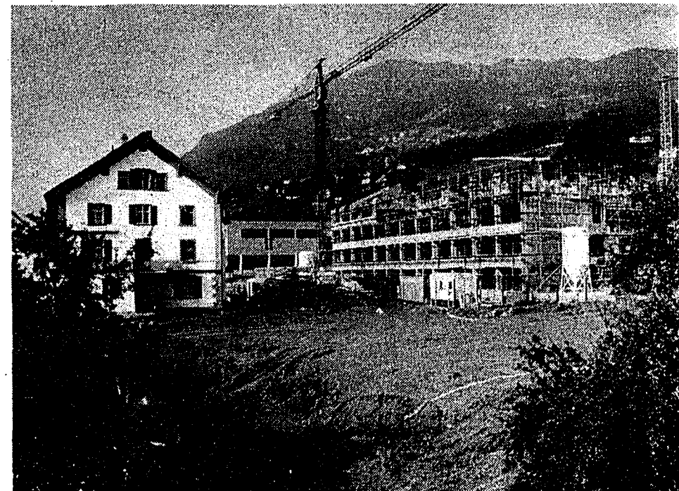
Auf diesem Areal wird in den nächsten eineinhalb Jahren der Neubau zum Betreuungszentrum St. Mamertus in Triesen entstehen. Das heutige Bürgerheim (im Hintergrund links) wird dann in die Gesamtanlage integriert. Im Bild rechts erkennen wir den Rohbau der neuen Oberschule. (Bild: Eddy Risch)
