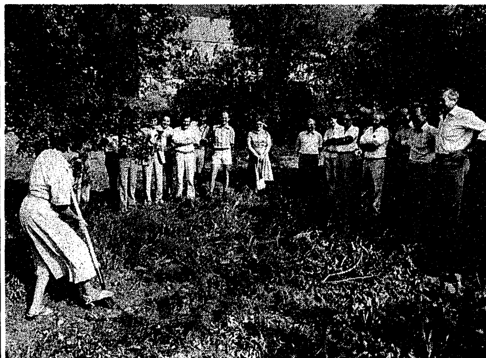
Spatenstich für das Betreuungszentrum Triesen am vergangenen Freitag nachmittag: die Gampriner Gemeinderätin Maria Marxer (links) weiss mit dem Spaten nicht weniger gut umzugehen als ihre männlichen Kollegen aus den Ratsstuben der übrigen Gemeinden des Landes. (Bild: Eddy Risch)
