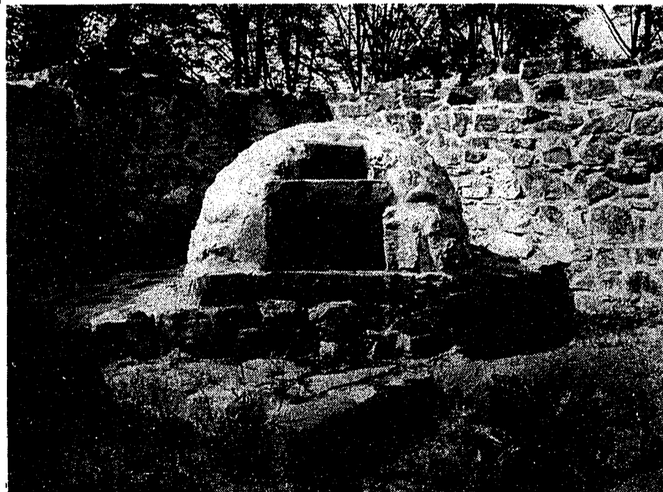
Blick in das Innere der Burgruine Alt-Schellenberg (untere Burg). Hier sehen wir die originaltreue Nachbildung eines Ofens. (Bild: Eddy Risch)
