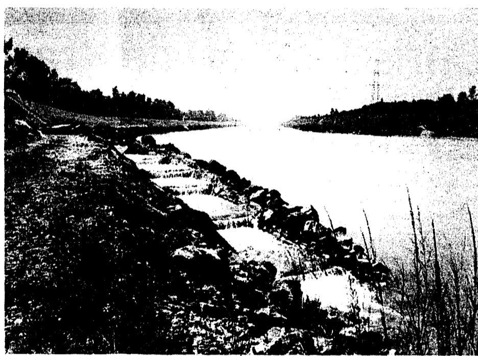
Da sich die Rheinsohle in den letzten Jahren immer mehr abgesenkt hatte, bestand für Fische keine Möglichkeit mehr, vom einen Gewässer ins andere zu wechseln. Unsere Aufnahme zeigt die nun in Betrieb genommene Fischbrücke, die es den Tieren ermöglicht, problemlos vom Rhein in den Binnenkanal zu gelangen.
