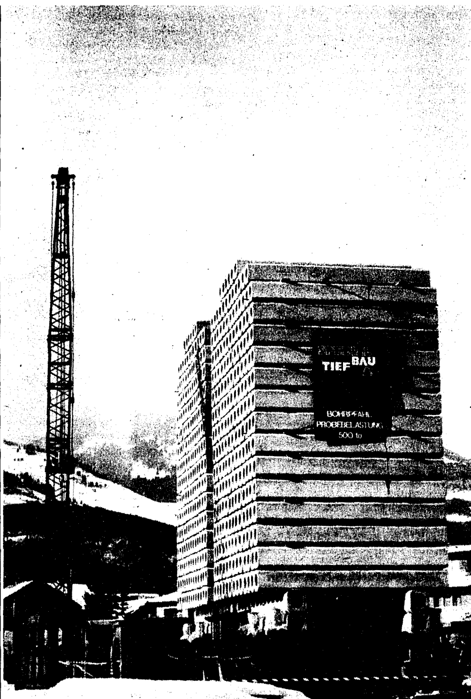
Auflast für den Belastungsversuch eines Probepfahls. Um die Reaktion der geplanten 28 m tiefen Pfähle testen zu können, wurde ein Probepfahl erstellt, der in einem Dreiwochenversuch etappenweise bis zu 500 Tonnen belastet wird.
