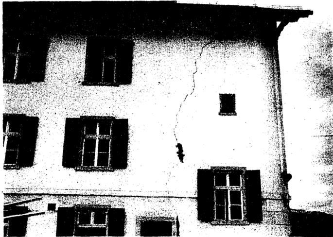
Entgegen den ursprünglichen Plänen wird der aus dem Jahre 1892 stammende Altbau nicht in die Gesamtüberbauung des neuen Vaduzer Spitals miteinbezogen. Risse an der Fassade, die während der Umgebungsarbeiten entstanden (unser Bild) hätten Sanierungsarbeiten ausgelöst, die am Ende teurer gekommen wären als ein Neubau dieses Mittelteils. Weder an der Gesamtkonzeption, noch an den Kosten und Terminen des Krankenhausbau hat sich dadurch etwas geändert.
