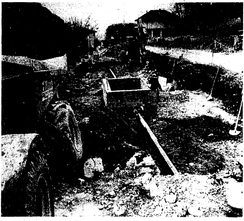
Das derzeit wichtigste Tiefbauprojekt in der Gemeinde Gamprin: Die Strassenkorrektur Gamprin innerorts. Unser Archibild vom Spätherbst 1977 zeigt die 1. Etappe, die bereits ausgebaut ist.
