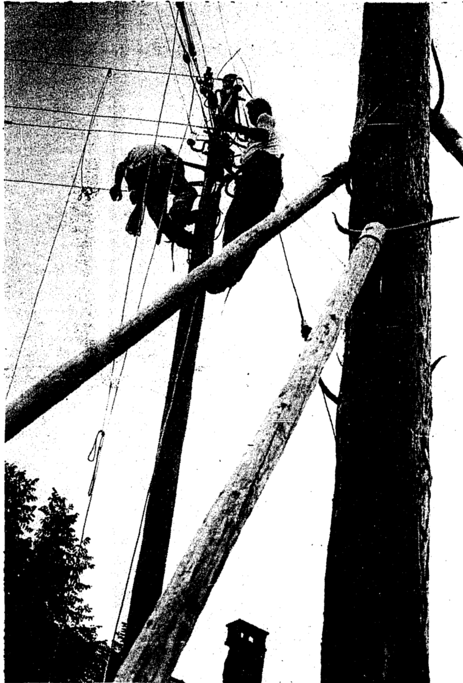
Die LKW sind ein umfassendes Dienstleistungsunternehmen, in dem alle Zweige zusammenarbeiten müssen, um einen reibungslosen Betriebsablauf zu gewährleisten: Arbeiten an Freileitungsanlagen. (Bild: F.-J. Meier)
