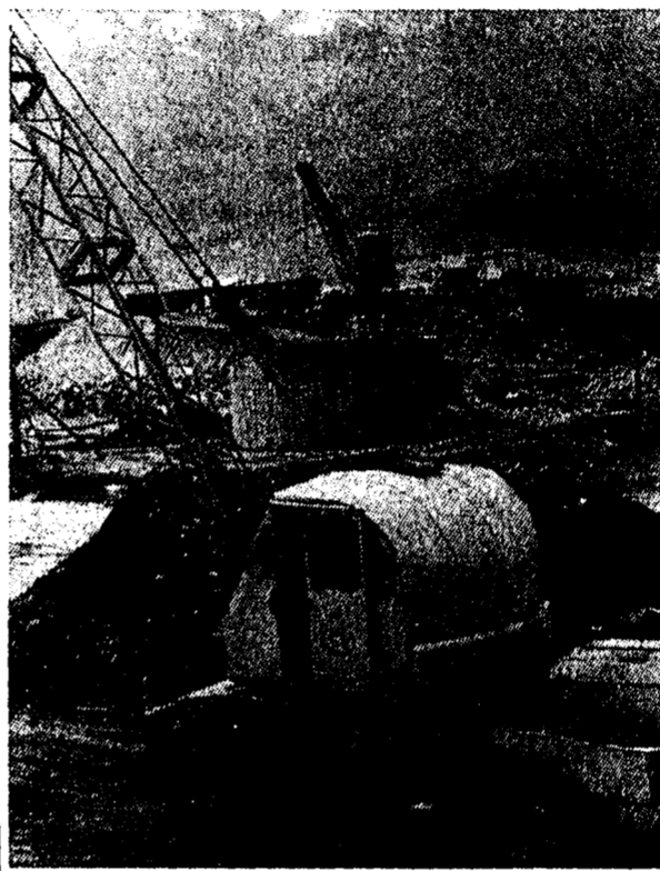
Bild oben: Die Baustelle der neuen Rheinbrücke Balzers. Im Hintergrund der bereits fertiggestellte Senkkasten auf der Schweizer Seite. - Bild unten: Die Gesamtansicht des Brückenprojektes von der alten Rheinbrücke her gesehen. (Foto: Peter)
