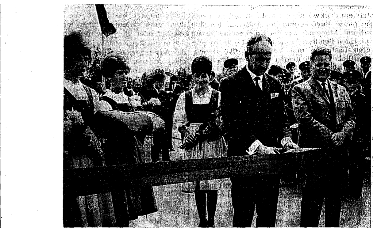
Regierungschef Dr. Batliner durchschneidet das Trennungsband auf der Brückenmitte. Neben ihm Regierungsrat Andreas Vogt.
