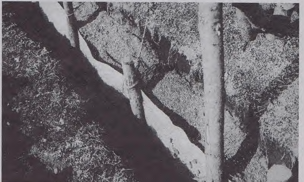
Rechts von oben nach unten: Eingeengte Baumscheibe mit versiegeltem, undurchlässigem Gehsteig / Baumscheibe mit durchlässigem Rundkies – zweckmässig und zugleich billig / Wurzelvorhang mittels Drahtgeflecht, Geotextil und einem mit Nährstoffen angereicherten, luft- und wasserdurchlässigen Substrat. 20–25 cm breit und 60–80 cm tief. Anwendung bei Bauarbeiten im Bereich von Baumwurzeln.
