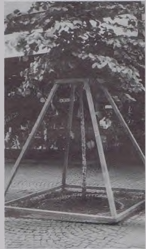
Vorbildlicher Stammschutz, Baumscheibe mit Baumrost, der wasser- und luftdurchlässig ist.
