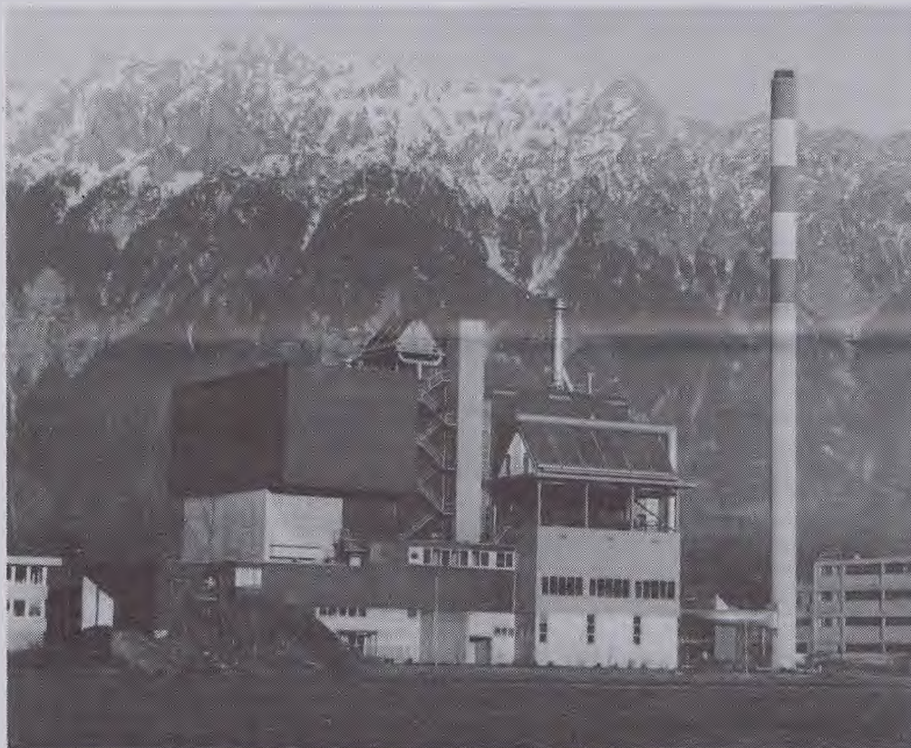
Die Kehrichtverbrennungsanlage (KVA) in Buchs ist der grösste Einzelemitter der Region. Die Verbrennungsgase von 60 000 Tonnen Müll jährlich gelangen ungereinigt in die Luft. Wenn Liechtenstein eine Deponie für die Rückstände der Rauchgaswaschanlage sowie den Elektrofilterstaub zur Verfügung stellt, ist der Weg frei für den Einbau einer solchen Anlage.
