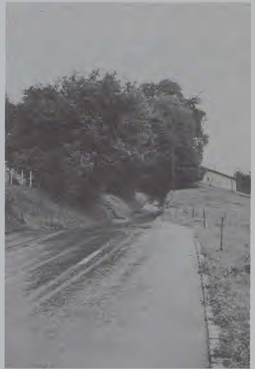
Badälstrasse: vor Beginn der zweiten Ausbaustappe
