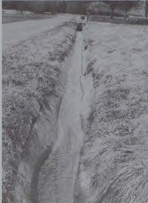
Einschalungen sind lebensfeindlich, dadurch werden die Fließgewässer aus dem Wirkungsgefüge der Landschaft herausgenommen.
