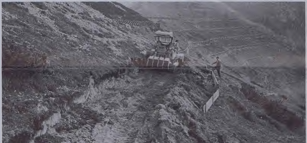
Mit einem Trax wurde auf gegen 2000 Meter über Meer am Sareiserjoch gearbeitet und ein neuer «Wanderwea» erstellt. Eine Baubewilligung sei hier nicht notwendig . . .
