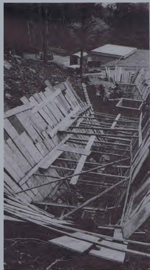
Bau der Brunnenstube oberhalb des Reservoirs
