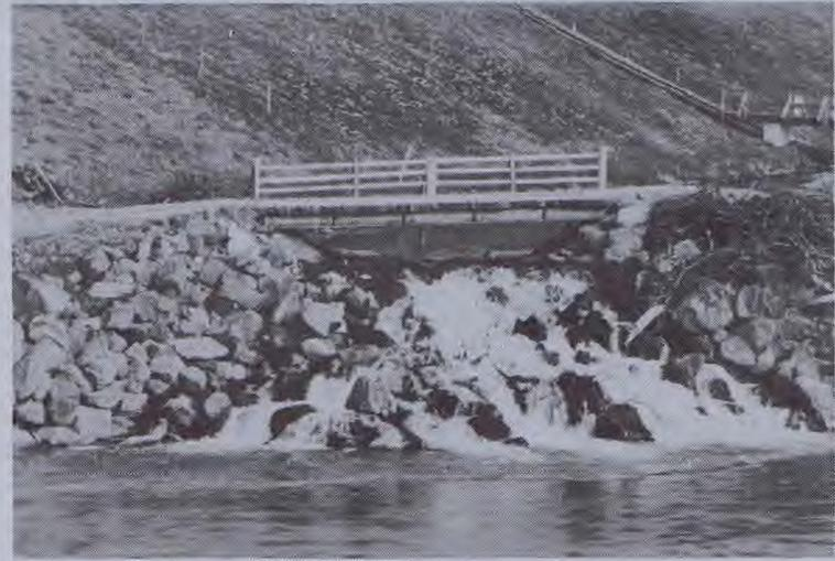
Nach der Rheinsohlenabsenkung um fünf Meter: Fischaufstieg nicht mehr möglich, 1981 saniert
