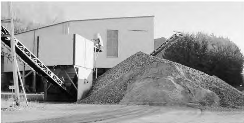
Kiesaufbereitungsanlage in Tuggen SZ
