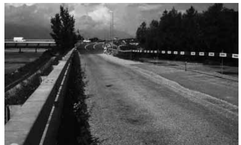
Fortsetzung folgt rechts: Vaduz, Triesen und das Tiefbauamt planen die Fortsetzung der Rheinstrasse.
