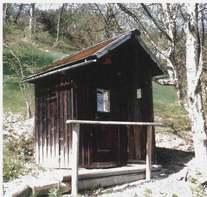
Grenzwächter-Schutzhütte Fehragut – Mauren
