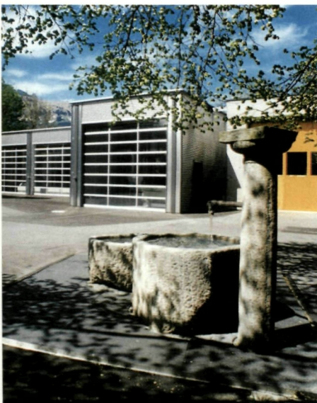
Kläranlage Bendern, privat
