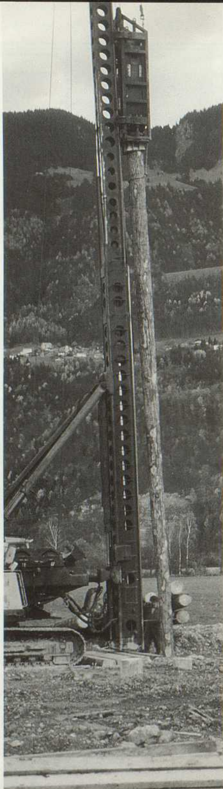
Ansetzen eines ca. 14 m langen Holzpfehles für den Rinderstall
