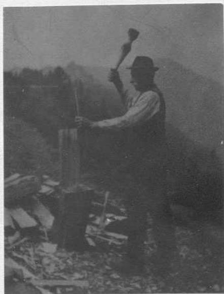
An einem ca. 30 cm langen Holzstiel befindet sich ein längliches, aus Eisen geschmiedetes Messer. Dieses setzte man auf den tannenen Klotz und hielt es mit der linken Hand. In der andern Hand führte der "Schindlamacher" den "Holzchnebel" (siehe Bild). Durch Schlag auf das Eisen spaltete man Stück um Stück ab. Nachher bedurfte es nur noch der Säuberung der Schindeln mittels eines Beiles.
