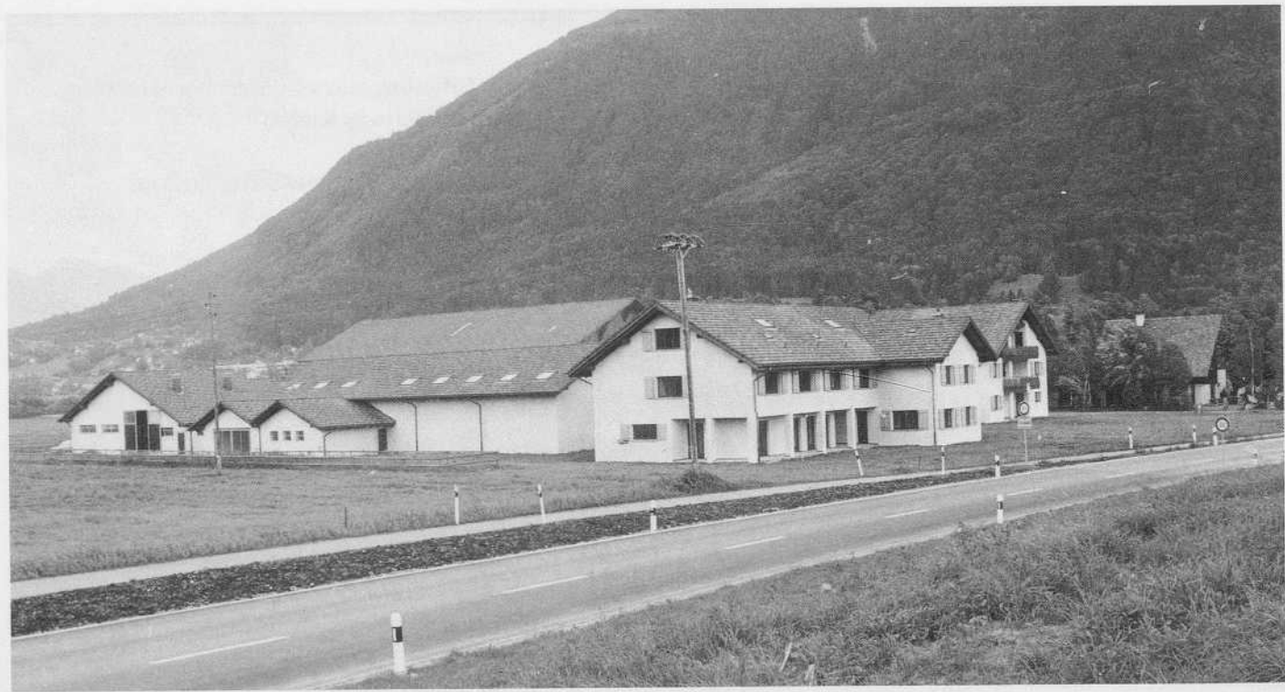
Das Gesamtprojekt fügt sich harmonisch in die Landschaft ein und wurde grosszügig als U-Form mit einem Innenhof geplant, wobei Wert darauf gelegt wurde, dass die verschiedenen Gebäude erweitert werden können. Blick von der Hauptstrasse Mauren-Schaanwald.
