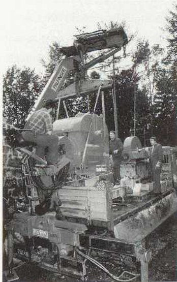
Abladen der Maschinengruppe im Trinkwasserkraftwerk in Vaduz im Oktober 1994
