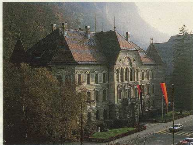
Regierungsgebäude in Vaduz
