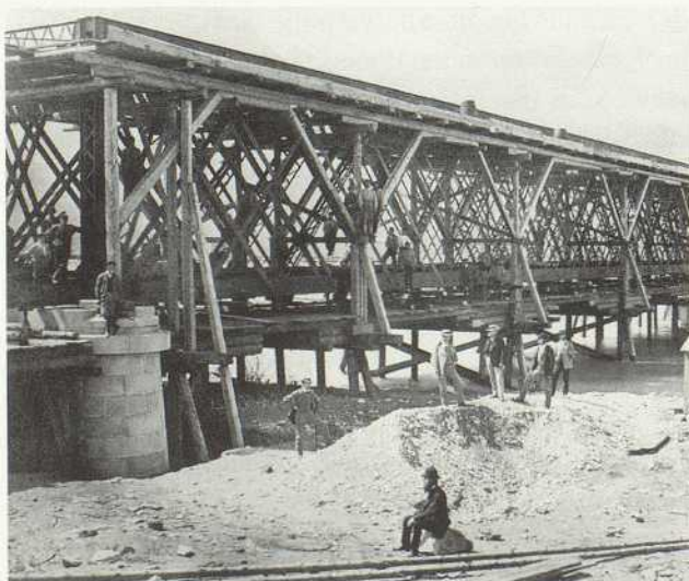
Bau der Brücke
