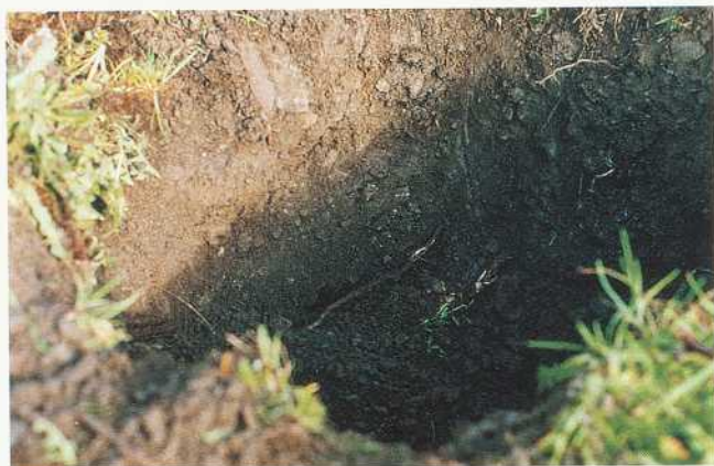
Schlitz 1: Herawingert, unterhalb Torkel. Unter 0,2–0,3 m Humus bis zur Endtiefe des Schlitzes (0,5 m) ziemlich feiner Boden; Grobkomponenten selten über 3 cm Durchmesser (vgl. Abb. 3, Kornverteilung). Umgelagertes respektive verschwemmtes Material aus der Zeit vor der Begrünung des Weinbergs. Die Mächtigkeit des abgeschwemmten Materials nimmt vom Torkel bis hinab zur Landstrasse zu
