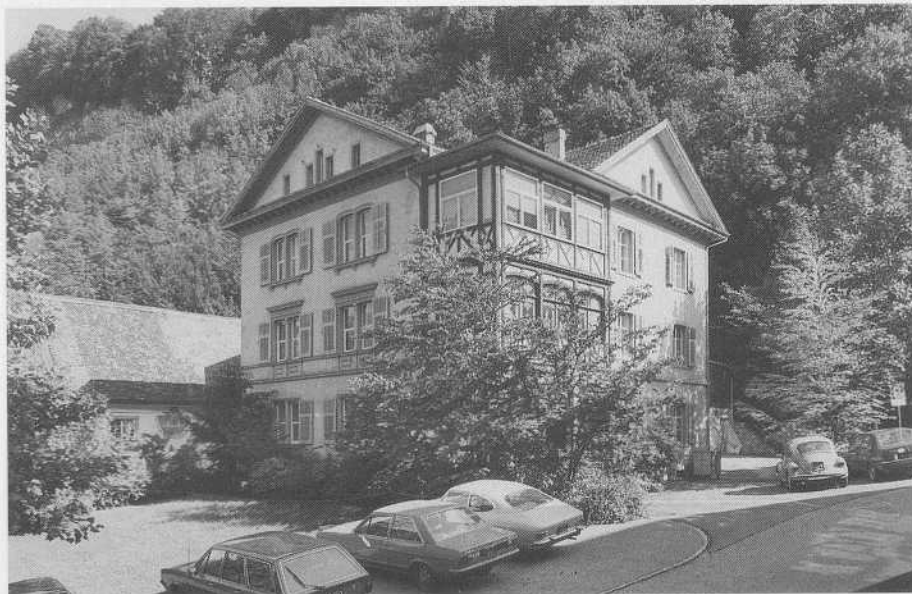
Schädlerhaus, Zustand vor der Renovation; Aufnahme: Walter Wachter, 1986
