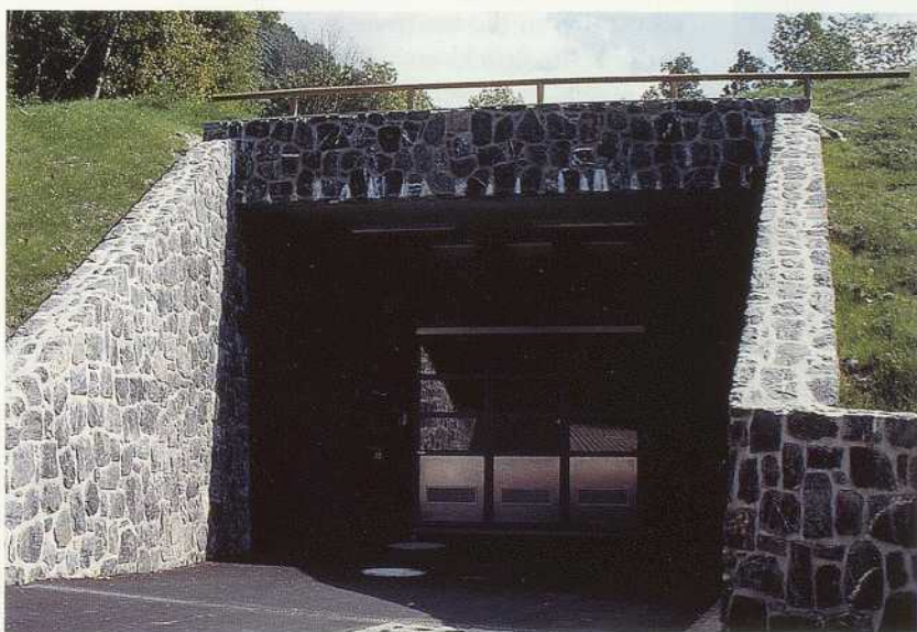
Die Eingangspartie des neuen Trinkwasserkraftwerks im Schlosswald
