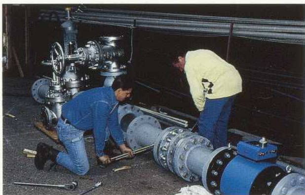
Montage von Rohrbruchsicherungen
