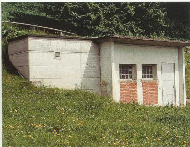
Pumpwerk auf Gaflei
