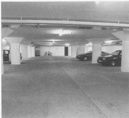
Zivilschutzraum mit Doppelnutzung als Tiefgarage.
