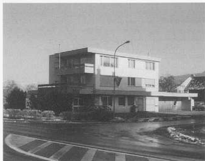
Ansicht von südwest vor und nach den Erweiterungsbauten.
