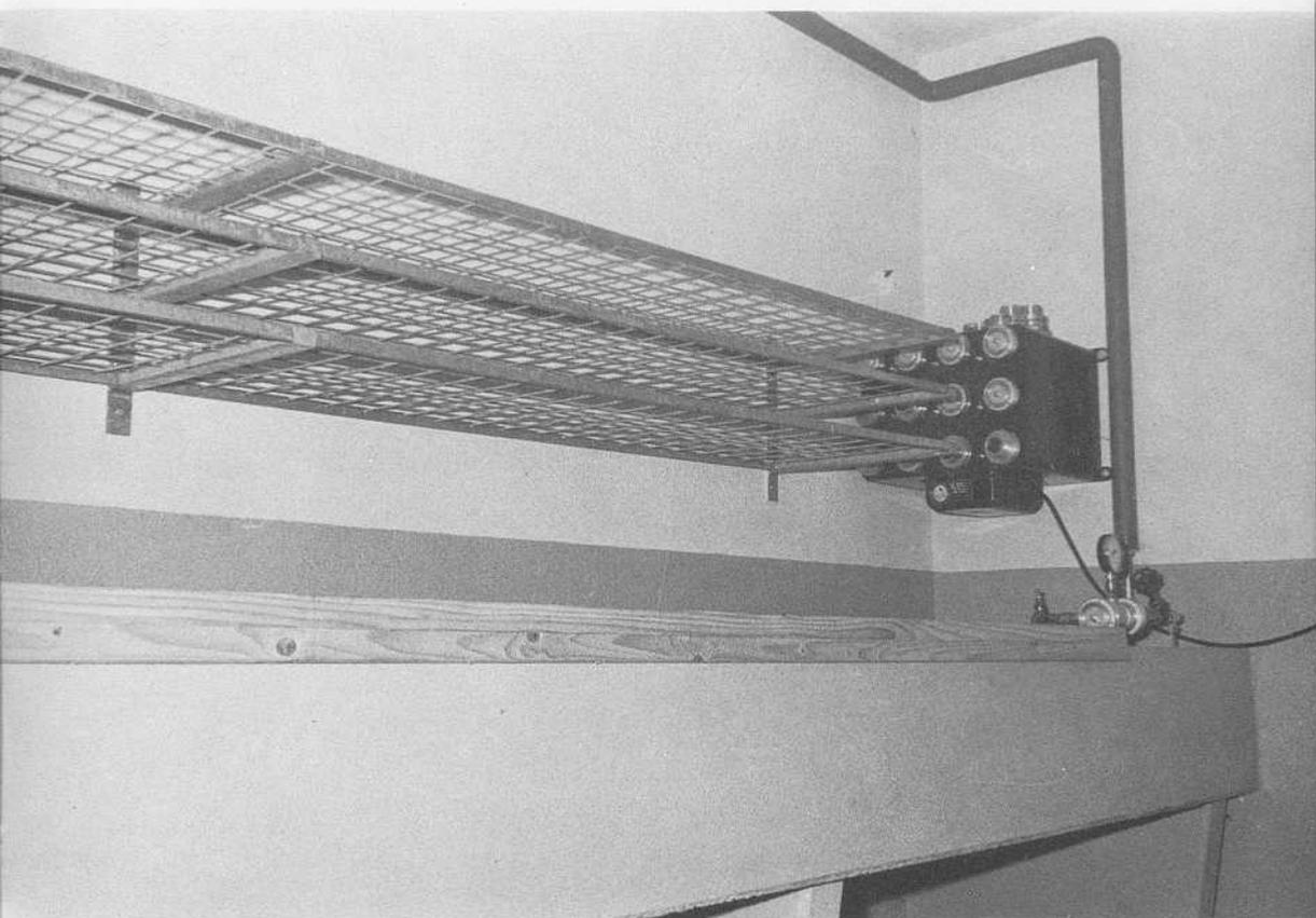
Die neue Schlauchtrocknungsanlage. Nasse Schläuche werden an diesem Heißluftapparat angeschlossen und so getrocknet, denn sie dürfen nicht über längere Zeit im nassen Zustand gelagert werden.
