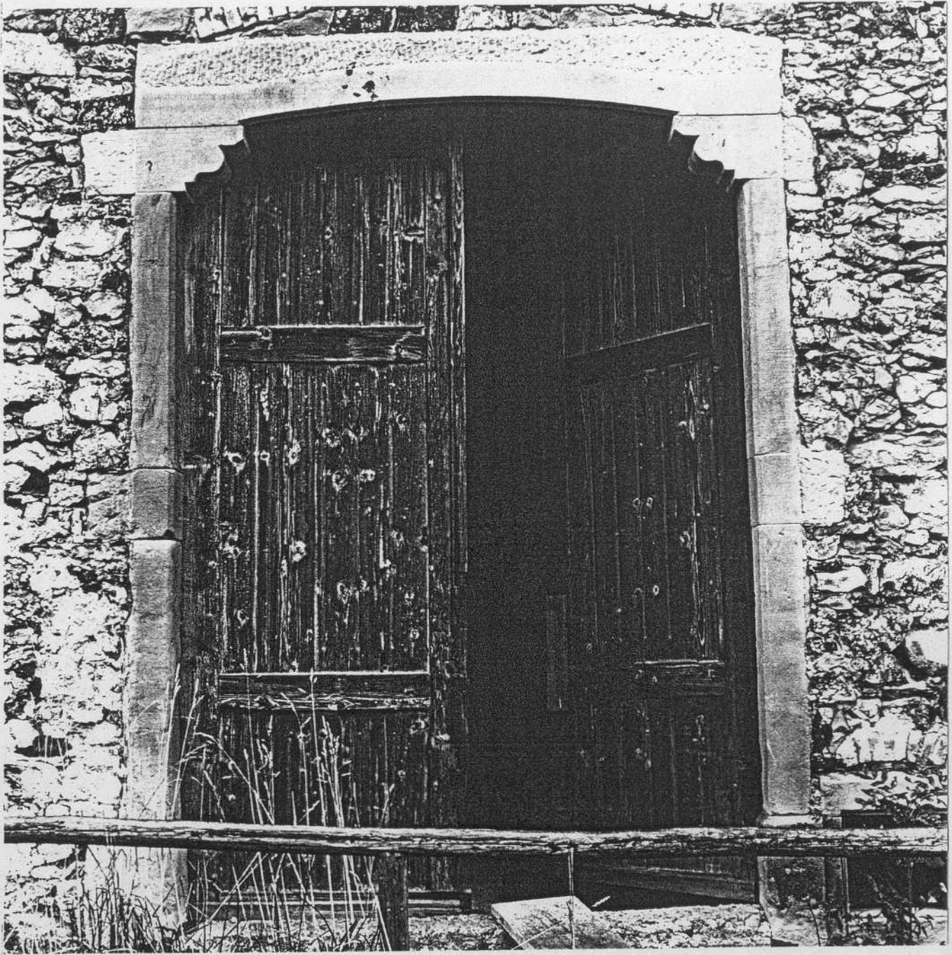
Abb. 42 Scheunentor mit Sandsteingewände in der Nordwestfassade des alten Pfarrhauses nach dem Umbau von 1875.
