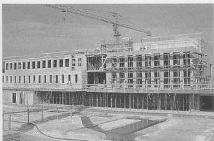
Rohbaufertigstellung Trakt Motorfahrzeugkontrolle
