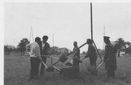
Der Spatenstich am 29. August 1988
