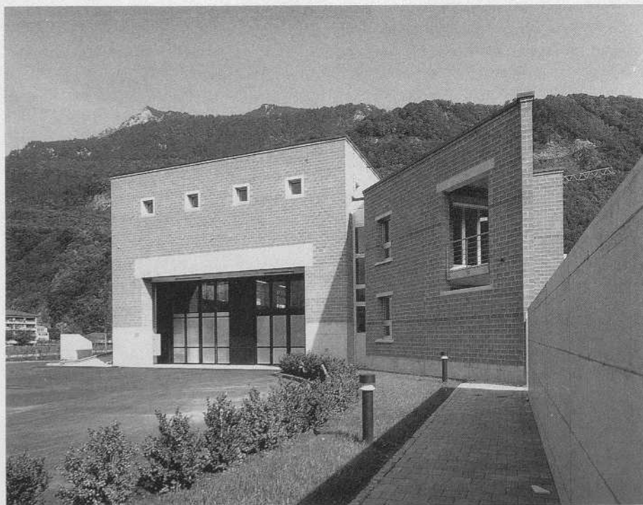
Teilansicht von Westen mit Motorfahrzeugprüfhalle und Abwartwohnung
