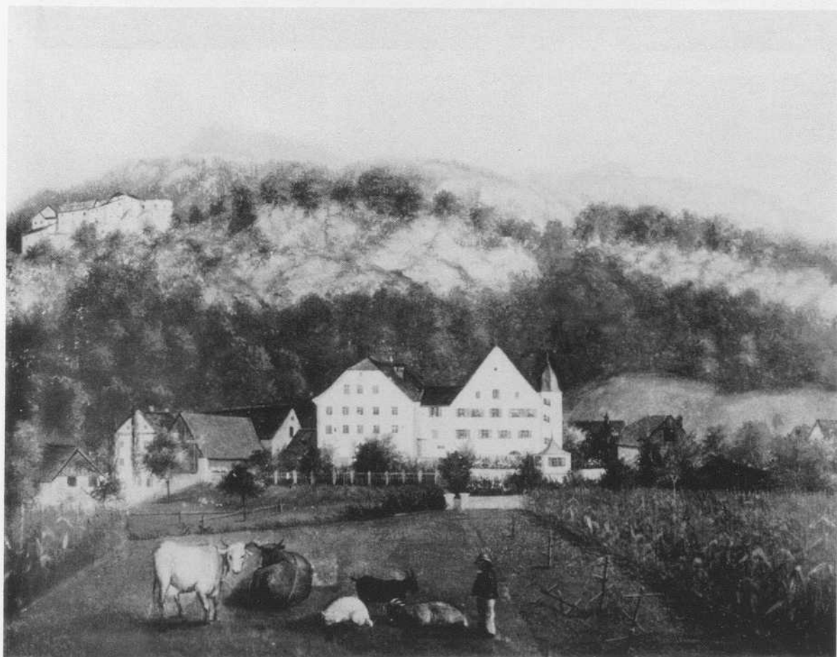
Die neue Pfarrkirche, die Florinskapelle und der „Tschaggaturm“, von Balzer Blick vom „Toniäule“ auf Landvogtei und Taverne
