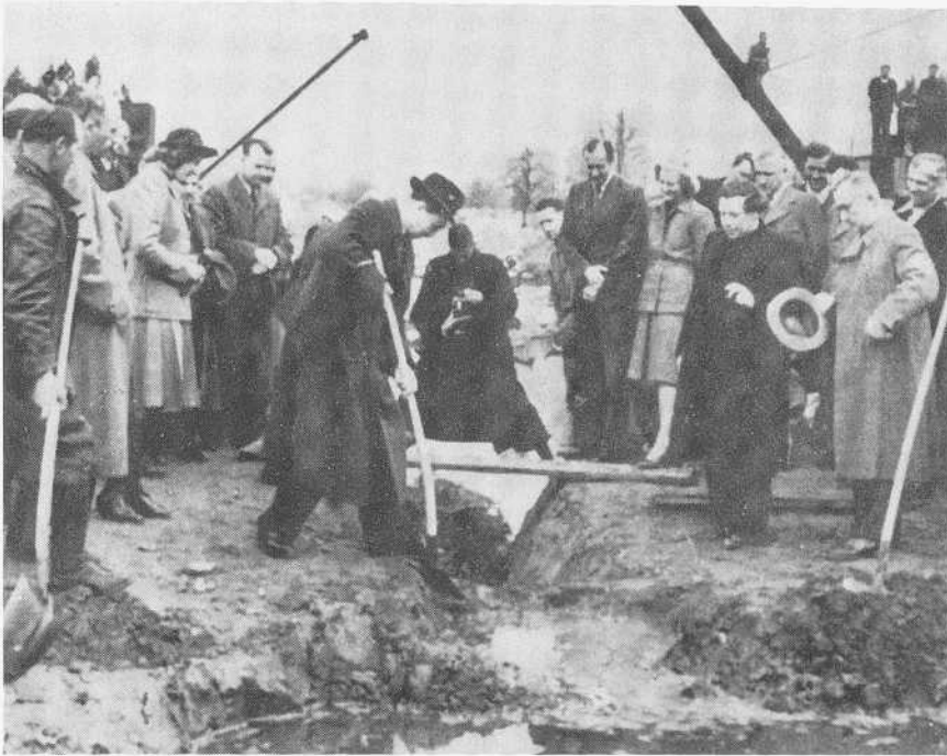
Letzter Spatenstich am Binnenkanalbau 1943 in Triesen durch seine Durchlaucht den Landes- fürsten
