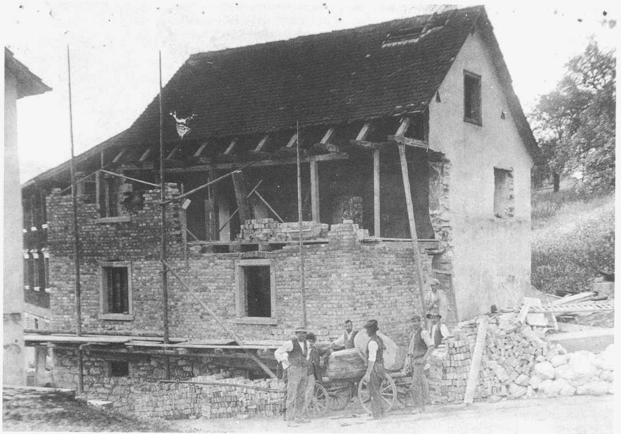
Der Umbau der alten Mühle
