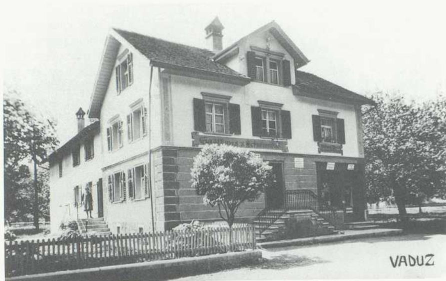
Gasthaus zum Schwimmbad
