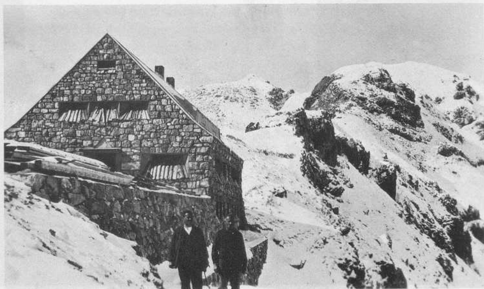
Bau der Pfälzerhütte im Jahre 1928
