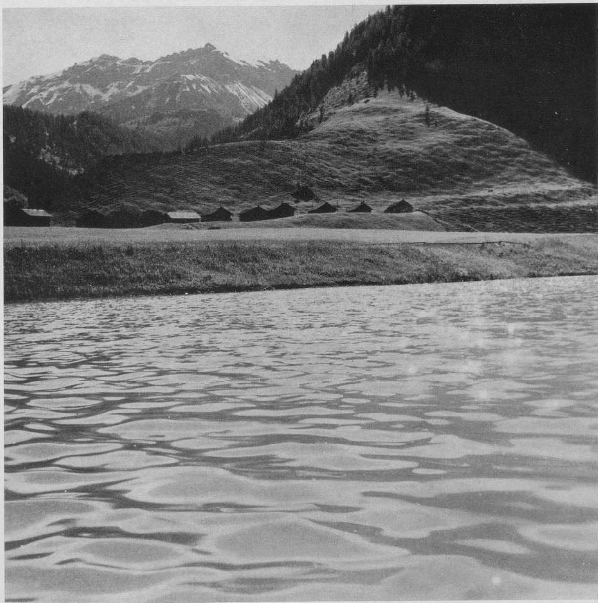
Stausee im Steg Barrage at Steg Barrage au Steg
